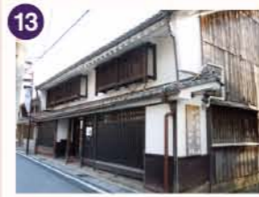
13 しょうぶ屋 江戸時代末期の町家を改装した戦国グッズ専門店。正面の白壁と路地に面した板壁が特徴的。周辺には江戸時代の町家がよく残っている。
