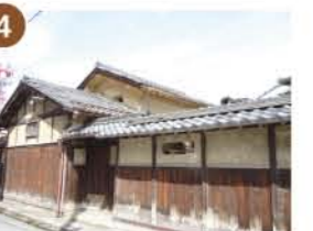
4 杉本家住宅 彦根藩の表医師岡島家の屋敷で、江戸時代の建物が残っている。昭和初期も医院として使われていた。屋根に鍾馭さんがいる。
