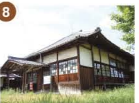
8 金亀会館 藩校弘道館の講堂。現在の西中学校運動場にあったが、大正12年、現在地に移築された。藩校唯一の現存建物で、市指定文化財。
