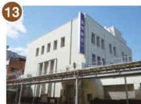
13 滋賀銀行彦根支店 大正14年、百三十三銀行本店として建てられた。当時は珍しかった鉄筋コンクリート造。装飾を抑え、石張りの壁の存在感を際立たせている。
