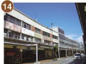
14 銀座防災街区 昭和36~48年、木造の町並みを鉄筋コンクリートのビル街に建て替えた。当時制定された防災街区造成法を全国に先駆けて取り入れたもの。
