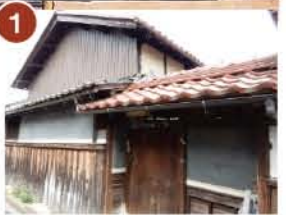
1 北川家住宅 現存する善利組の足軽組屋敷。武士の格式を示す「おもてげんかん」がある。現在は隣地と一体になっているがもとは別の屋敷だった。市指定文化財。
