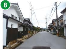
東表町の米宿跡 家並み(写真左)の向かい側の前川沿いに蔵(同右)が並び、「米宿」の機能を担っていた。古い建物が数棟現存。前川の一部が埋め立てられ、広い道路になった。
